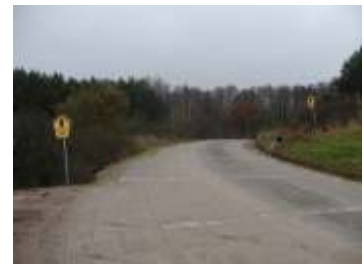
...und der gleiche Wege nach einer geförderten Wegebaumaßnahme
