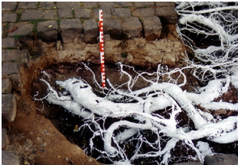
Abb. 7: Starkwurzeln von Sophora japonica in der Tragschicht. Der Schaden ist in dieser Tiefe trotz großer Wurzeldicken gering.
